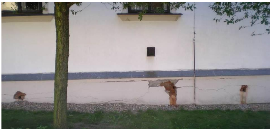
Obrázek 5.: Pohled na sokl severní stěny kaple se třemi jádrovými vrty (před zapravením).
