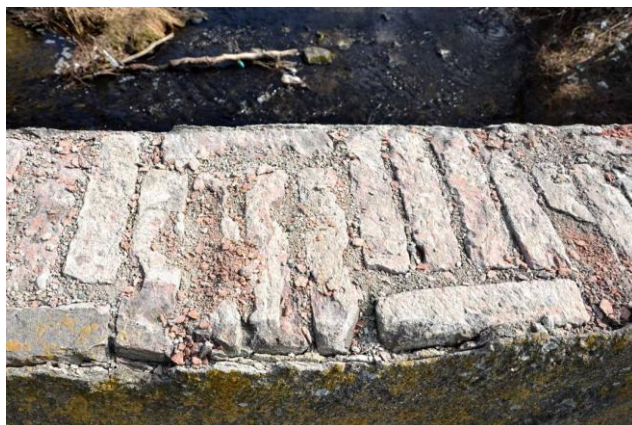
Obrázek 2.: Pohled na korunu parapetu na návodní straně mostu, cihly jsou umístěny specifickým způsobem popsáním výše.
