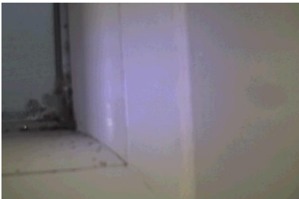
Obrázek 2.: Kondenzace na zasklení a plíseň na rámu okna
