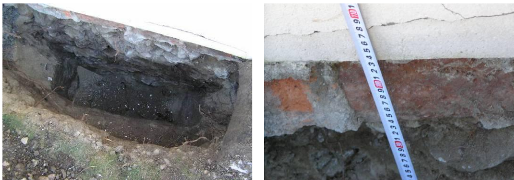
Obrázek 2.: Kopaná sonda k základům (po levé straně zdi lodi), vpravo ověření hloubky základové spáry.
