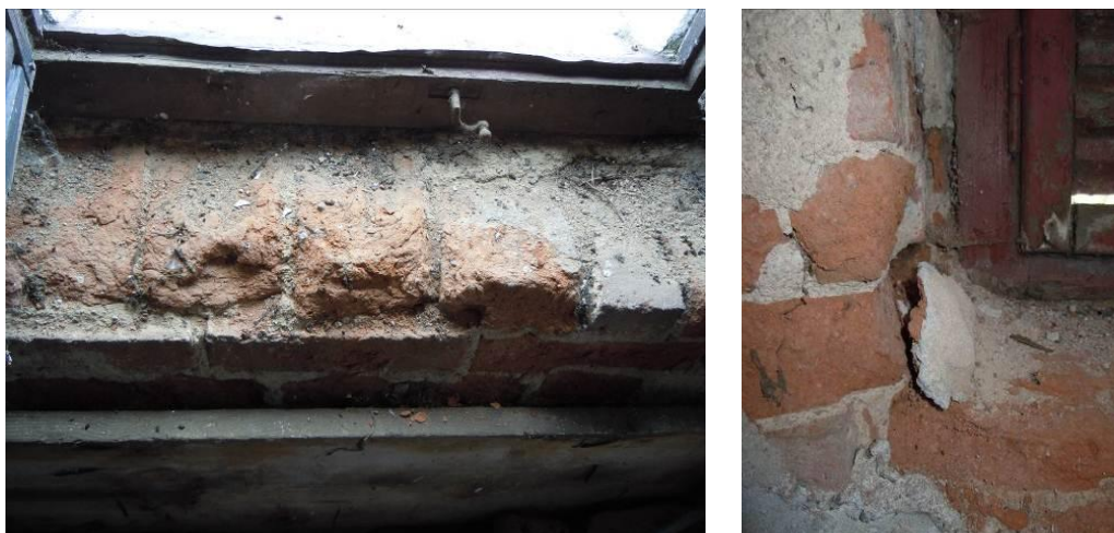
Obrázek 11.: Degradace cihel pod okny věže v důsledku zatékání.
