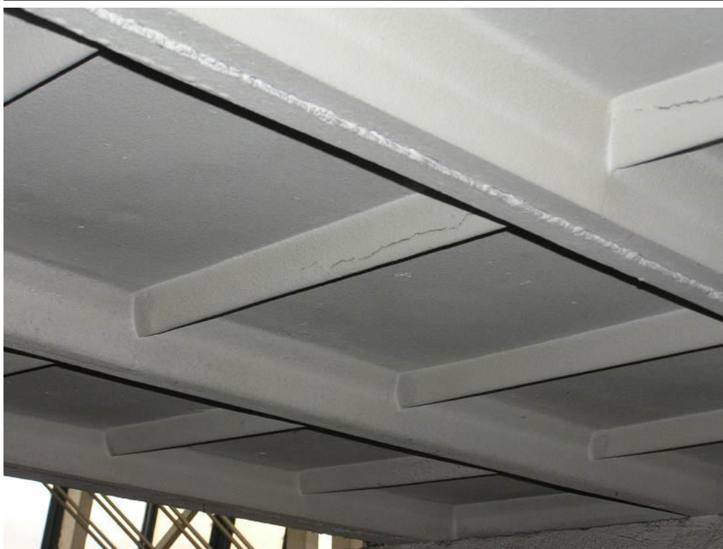
Obrázek 3.: Narušené střešní panely
