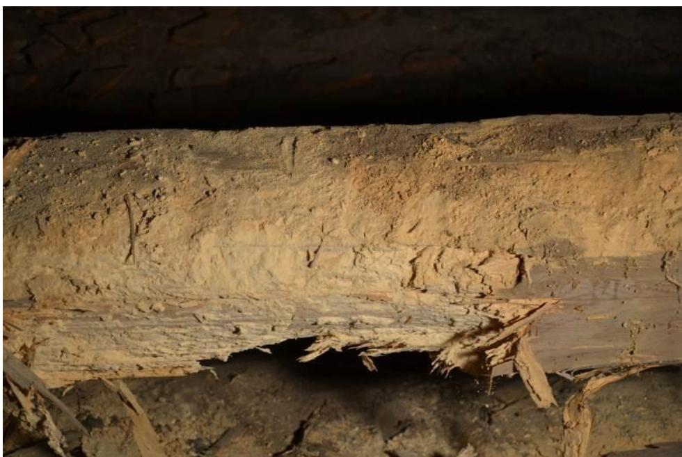
Obrázek 14.: Narušení vazného trámu červotočem.
