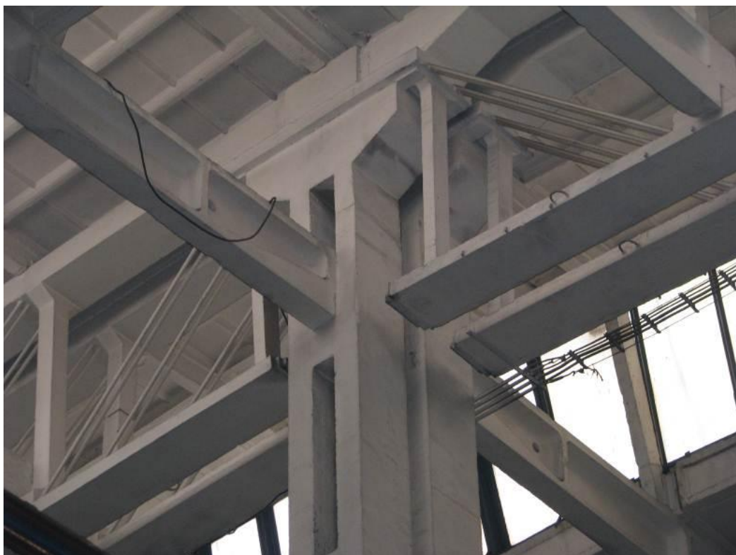
Obrázek 2.: Detail uložení předpjatého vazníku na sloup
