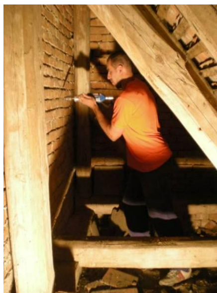
Obrázek 8.: Zjišťování pevnosti v tlaku malty pomocí mechanické Kučerovy vrtačky.
