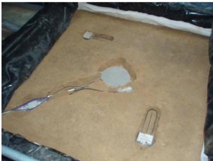
Obrázek 10.: Instalace snímačů na 3. technologické vrstvě podloží (cca 550 mm výšky)
