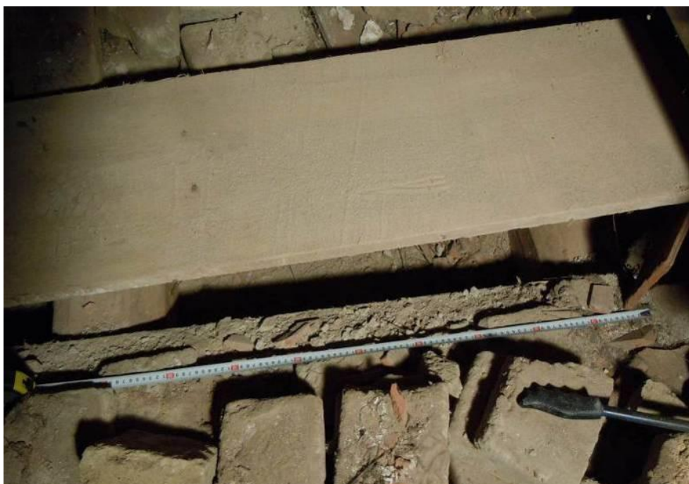
Obrázek 12.: Sonda S1 do stropu kaple.
