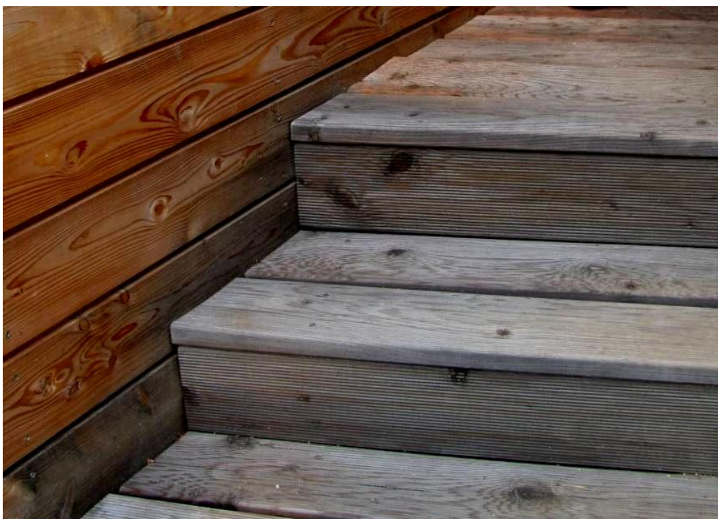
Obrázek 1.: V exteriéru déšť ze dřeva extrahuje a vymývá hnědé produkty štěpení ligninu a dřevo šedne.
