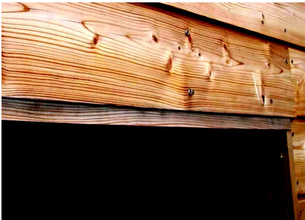
Obrázek 2.: Chybně vyřešený detail – ostění zarovnané s obkladem umožňuje zatékání dešťové vody a důsledkem toho dřevo šedne.
