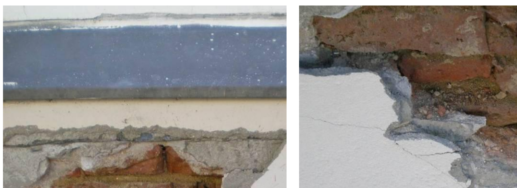
Obrázek 3.: Vlevo je patrná vodorovná hydroizolace pod parapetem; vpravo je zachycena cementová omítka tvořená třemi vrstvami o mocnosti přibližně 30 mm.
