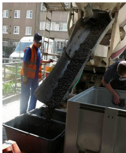
Obrázek 2.: Beton vysypaný do prvního kalfasu byl z velké míry tvořen hrubým kamenivem.
