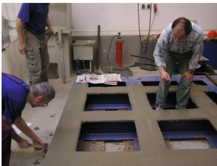
Obrázek 5.: Přípravné práce před položením nerezové vany na rošt
