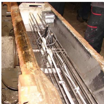
Obrázek 2.: Instalace optovláknových extenzometrů SOFO do monitorovaných předem předpjatých betonových pražců B91 S, ŽPSV a.s.
