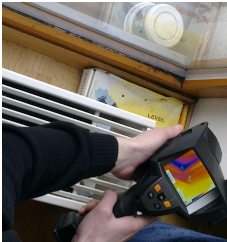
Obrázek 3.: Měření výplně otvoru termovizní kamerou
