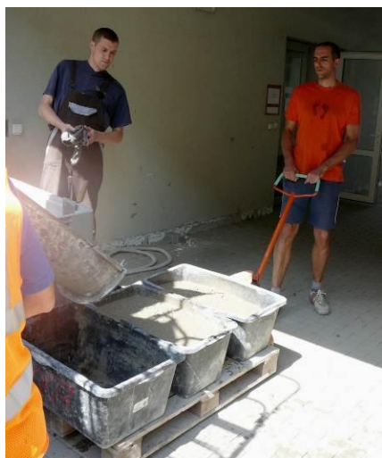
Obrázek 1.: Vysypání betonu z autodomíchače do předem připravených kalfasů.
