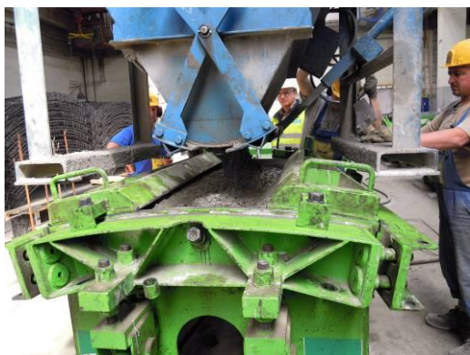
Obrázek 1.: Pohled do formy při betonování vláknobet. klenáku
