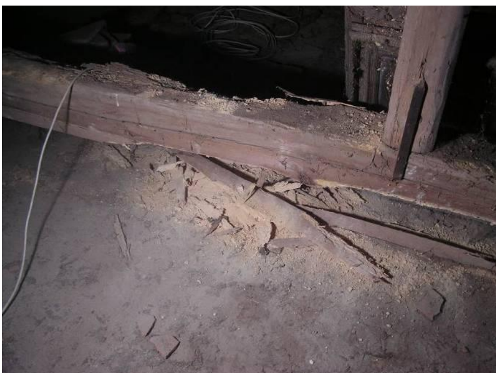
Obrázek 15.: Narušení vazného trámu krovu červotočem.
