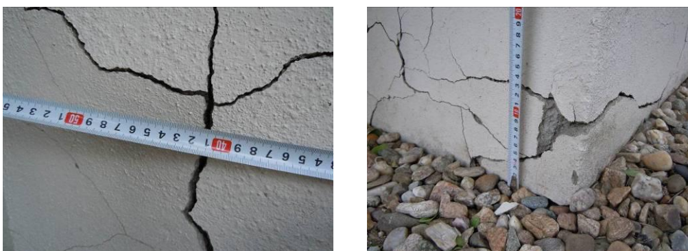
Obrázek 10.: Typické příklady trhlin v omítce soklu kaple: vlevo síť trhlin nalevo od vstupních dveří, vpravo popraskaná omítka jednoho pilíře.
