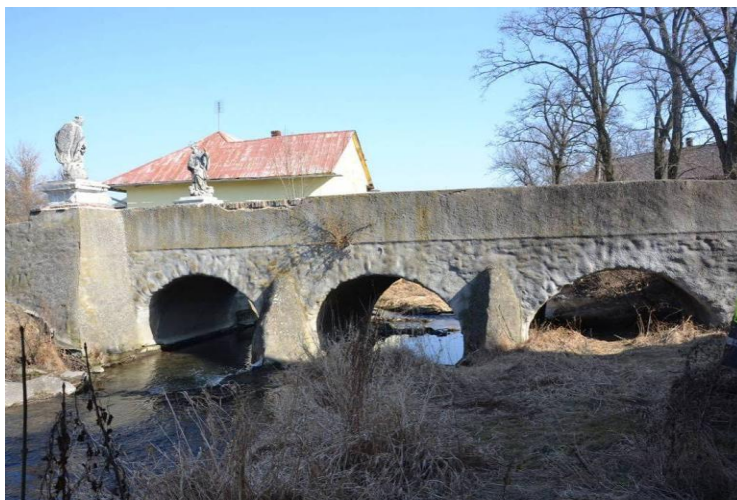
Obrázek 1.: Most ev. č. 36719-2 přes Brodečku v obci Dobromilice, okres Prostějov
