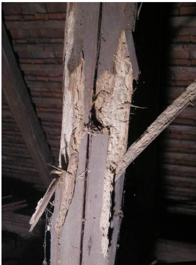
Obrázek 16.: Narušení sloupu plné vazby krovu červotočem.
