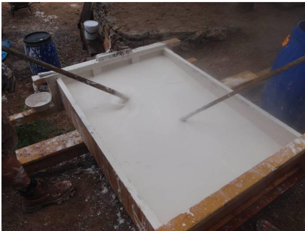
Obrázek 2.: Hašení vápna v hasnici
